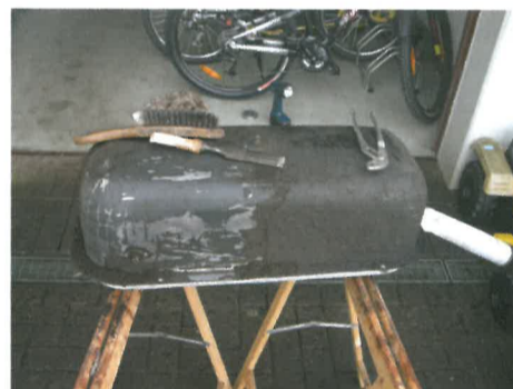
Tank während der Renovation
